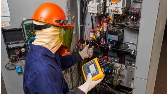
Uso de un registrador trifásico de calidad eléctrica Fluke 1738 para realizar un estudio de energía en un sistema mecánico
